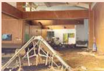
土石流が流れ込んだ小学校
